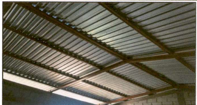
Foto 2: Sustitución de lámina, por lámina troquelada aluzin calibre 26 (aula 1)
