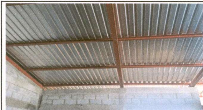
Foto 3: Sustitución de estructura de soporte de madera por metal (aula 1)
