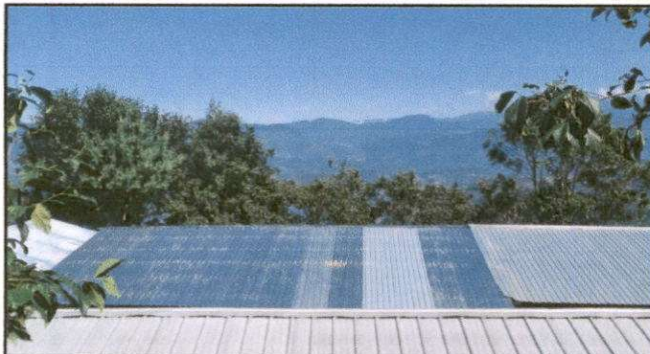
Foto 1: Sustitución de capote de lamina para lamina troquelada (aula 1)
